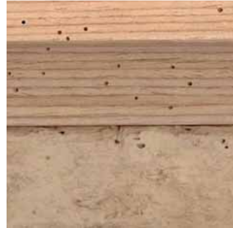
Schade van spinhoutkevers. Kenmerkend zijn de ronde uitvliegopeningen met een diameter van 1 tot 2 mm (boven) en talrijke, ronde boorgangen binnenin het hout (onder) (foto Uwe Noldt)
